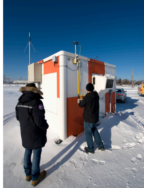
Installation de l'antenne du TPRU sur le bâtiment du Localizer (Pierre Gillard).
